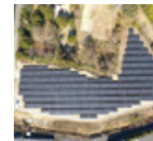
S-31 CS山口市発電所
