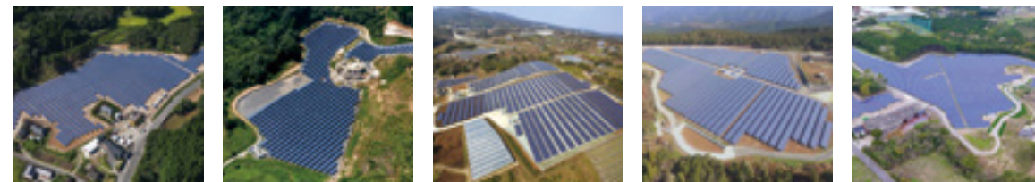
S-06 CS伊佐市第三発電所 S-07 CS笠間市第二発電所 S-08 CS日出町発電所 S-09 CS芦北町発電所 S-10 CS南島原市発電所(東)、同発電所(西)
