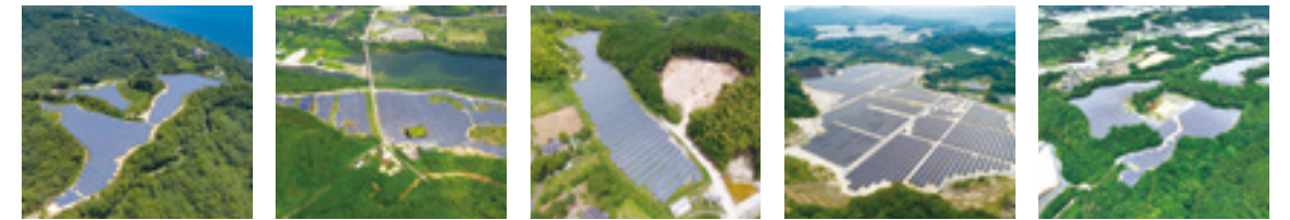
S-26 CS福山市発電所 S-27 CS七ヶ宿町発電所 S-28 CS嘉麻市発電所 S-29 CSみやこ町犀川発電所 S-30 CS笠間市第三発電所
