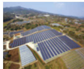
S-08 CS日出町発電所
