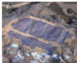
S-11 CS皆野町発電所
