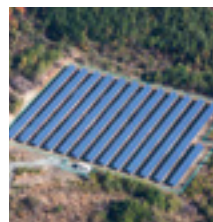
S-14 CS郡山市発電所
