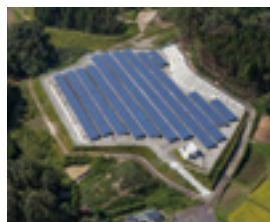
S-02 CS伊佐市発電所
