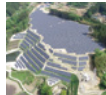
S-25 CS大河原町 発電所
