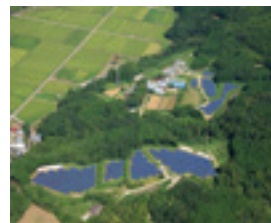
S-12 CS函南町発電所
