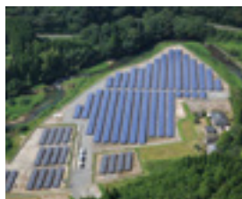
S-01 CS志布志市発電所
