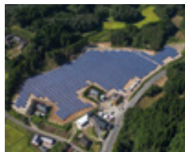
S-06 CS伊佐市第三発電所
