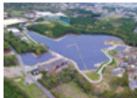
S-10 CS南島原市発電所(東)、 同発電所(西)
