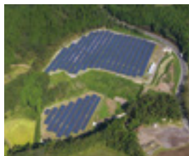
S-05 CS湧水町発電所
