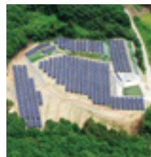
S-19 CS美里町発電所
