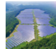
S-17 CS大山町発電所(A)、 同発電所(B)
