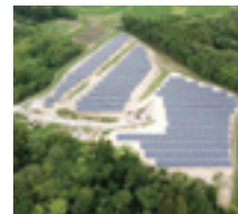
S-23 CS大崎市化女沼 発電所
