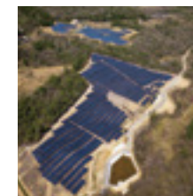
S-16 CS恵那市発電所
